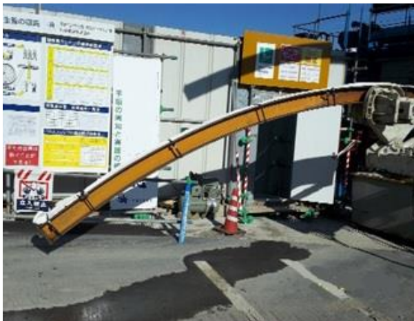
①台車にジャケット付の支保工をセット状況を
