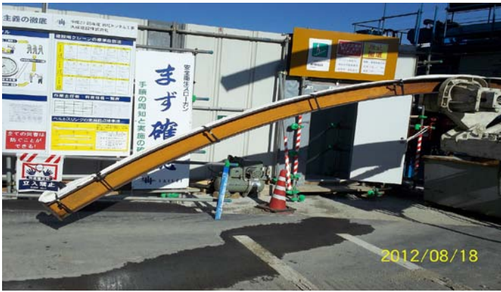
①台車にジャケット付の支保工をセット状況
